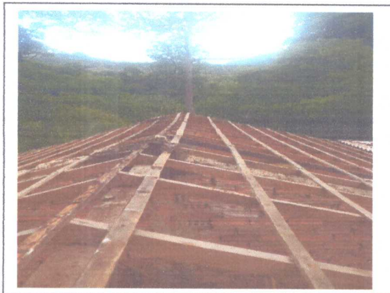
RETIRADA DAS TELHAS FRANCESAS
