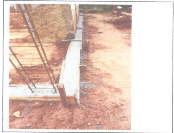
CONCRETAGEM VIGA BALDRAME
