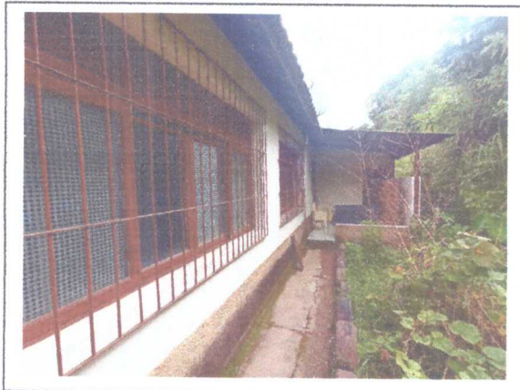
RETIRADA DAS GRADES E JANELAS
