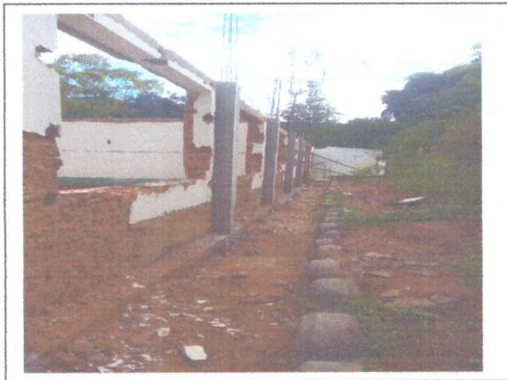
CONCRETAGEM DOS PILARES
