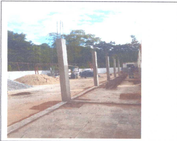
CONCRETAGEM DOS PILARES
