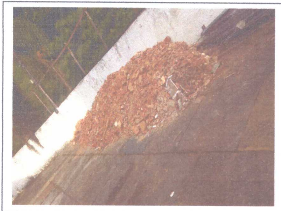
DEMOLIÇÃO – RETIRADA DE MATERIAL
