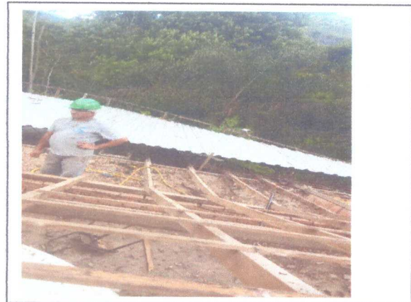
RETIRADA DAS TELHAS FRANCESAS
