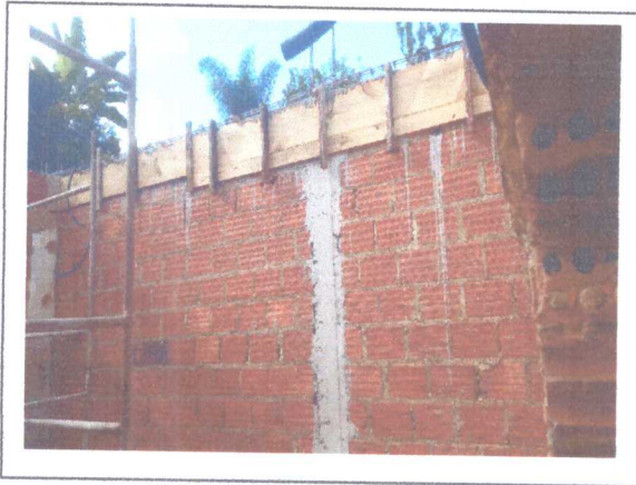
ALVENARIA / PILARES E VIGAS
