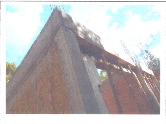
PILARES E VIGAS
