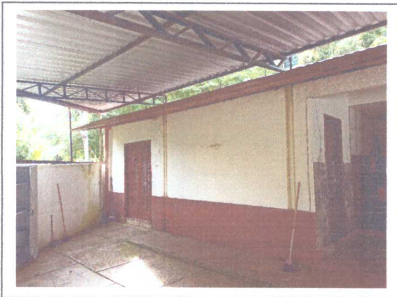
RETIRADA TELHA METALICA
