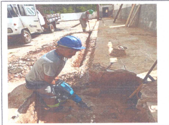
ESCAVAÇÃO DE VALA E DEMOLIÇÃO
