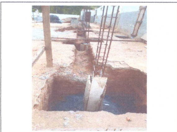
ESCAVAÇÃO E CONCRETAGEM DAS SAPATAS E VIGAS BALDRAMES
