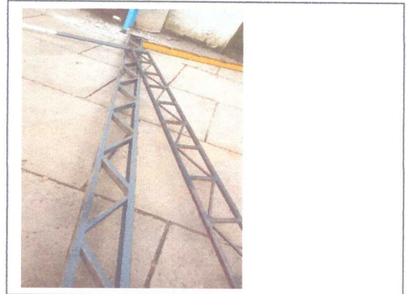
RETIRADA ESTRUTURA METALICA
