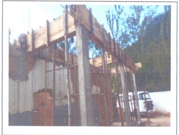
MONTAGEM DE FORMAS E CONCRETAGEM
