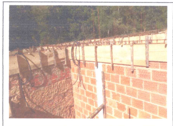
MONTAGEM DAS FORMAS E ARMAÇÃO
