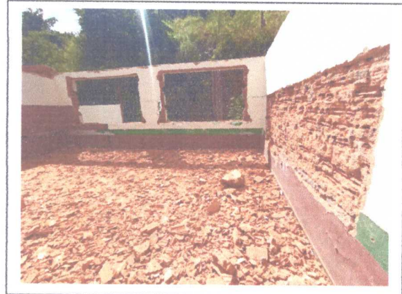
RETIRADA DAS GRADES E JANELAS / DEMOLIÇÃO DE ALVENARIA
