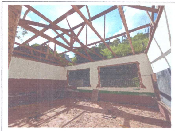
RETIRADA DO MADEIRAMENTO
