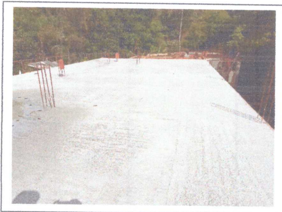
LAJE CONCRETADA
