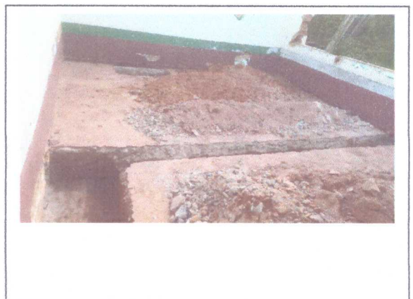
DEMOLIÇÃO E ESCAVAÇÃO
