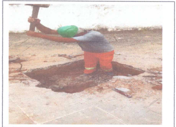
DEMOLIÇÃO ESTRUTURA DE CONCRETO
