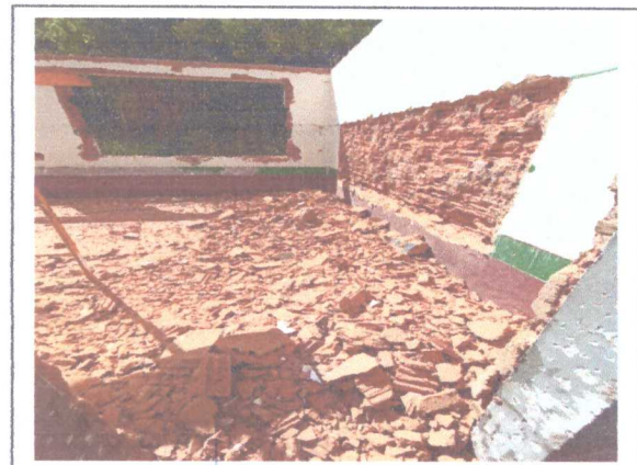
DEMOLIÇÃO ALVENARIA
